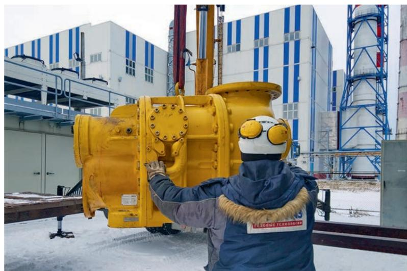
ФОТО 5. Демонтаж оборудования газоподготовки в ходе ремонтных работ на ПГУ-225 Сызранской ТЭЦ
