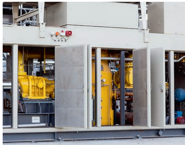
ФОТО 4. Оборудование газоподготовки для испытательных стендов «Невского завода»
