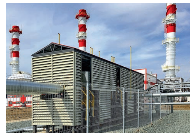
ФОТО 1. Энергоцентр Усинского месторождения. БППГ «ЭНЕРГАЗ» в эксплуатации
