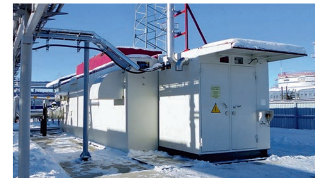
ФОТО 2. Установка для компримирования низконапорного попутного газа
