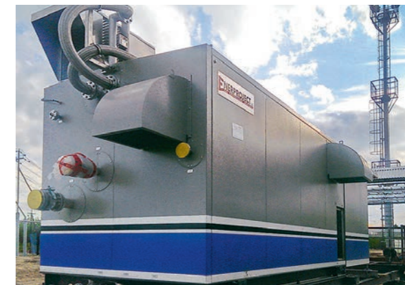
ФОТО 8. Вакуумная КС в составе УПСВ-4 Вахского месторождения
