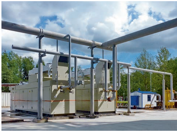
ФОТО 10. Многофункциональная СПГ для центра энергоснабжения ОАО «Ангстрем-Т»
