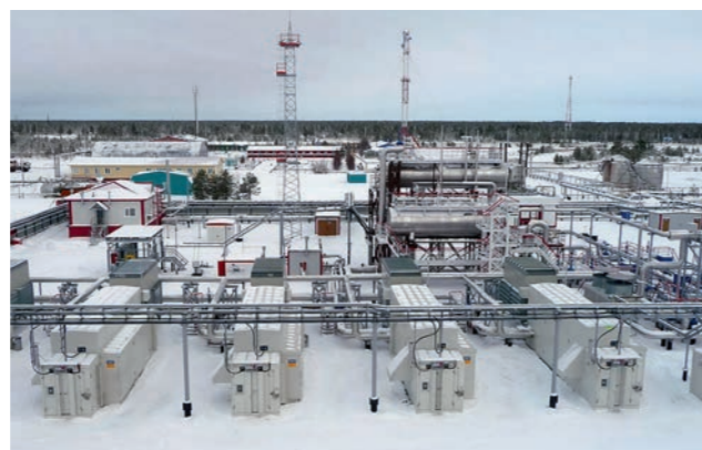
ФОТО 6. Модернизированные КУ на СКНС Алехинского месторождения
