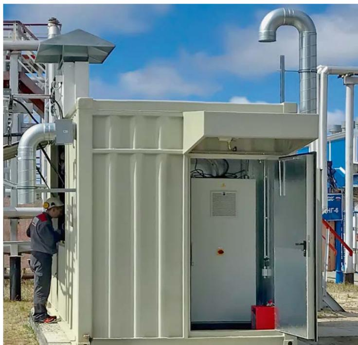
ФОТО 8. Отсек системы автоматизированного управления интегрирован в модуль установки
