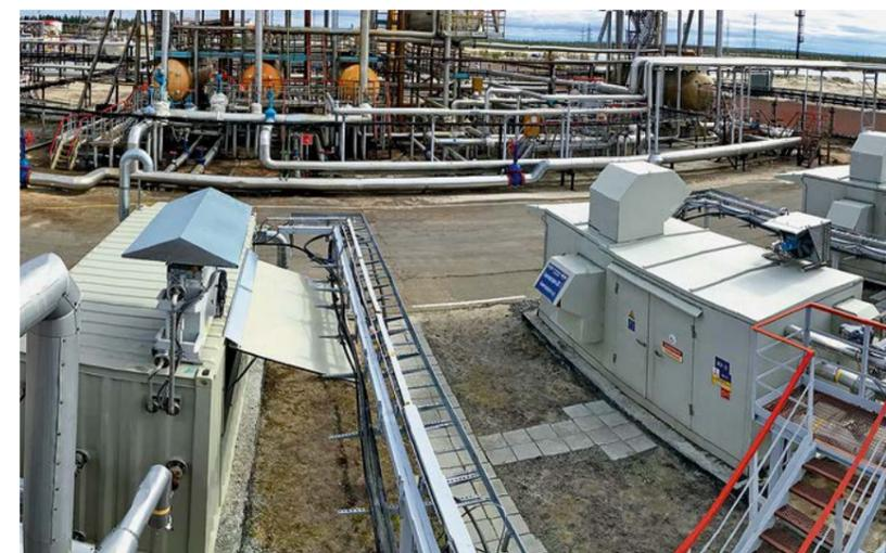
в штатную эксплуатацию введена малая газоконпрессорная установка (слева на нижнем фото). МГКУ вошла в состав ДКС низкого давления и предназначена для перекачивания попутного газа с входным давлением, близким к вакууму (0 ... 0,09 МПа).
