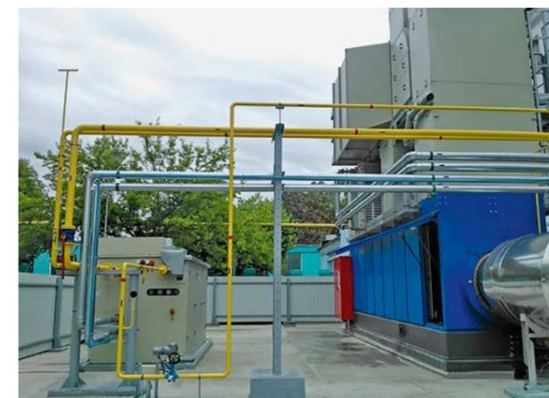
ФОТО 1. МГКУ «ЭНЕРГАЗ» в составе энергоцентра Минского комбината силикатных изделий
