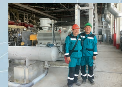
Сервис на площадке Сибур
