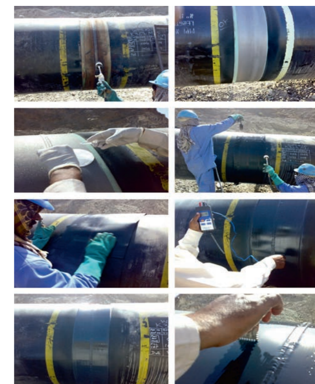
РИСУНОК 2. Применение термоусадочных рукавов
