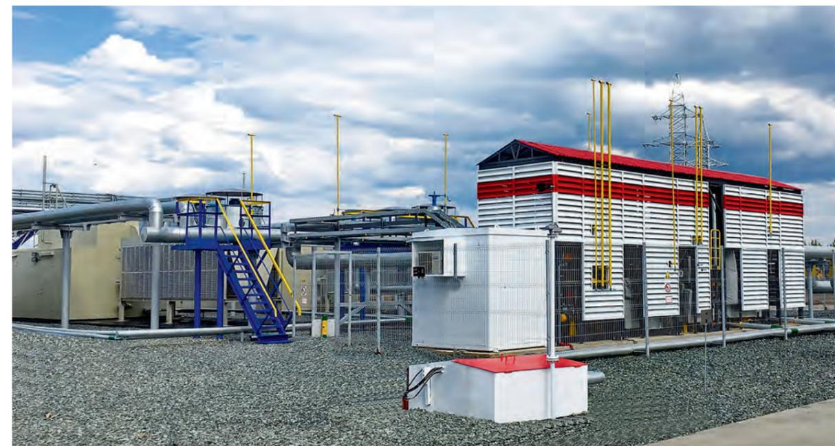
ФОТО 1. Система газоподготовки и газоснабжения «ЭНЕРГАЗ» для энергоцентра ООО «ЛУКОЙЛ-Коми»
