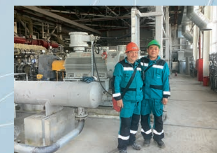
Сервис на площадке Сибур
