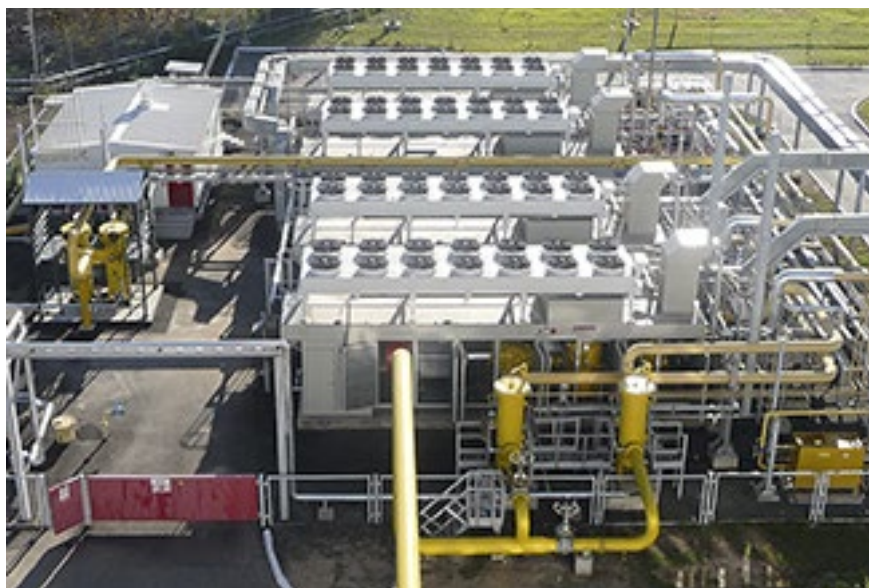
ФОТО 1. Система подготовки газа (ДКС, РДКС и БПТГ) для турбин ПГУ-110 Астраханской ГРЭС
