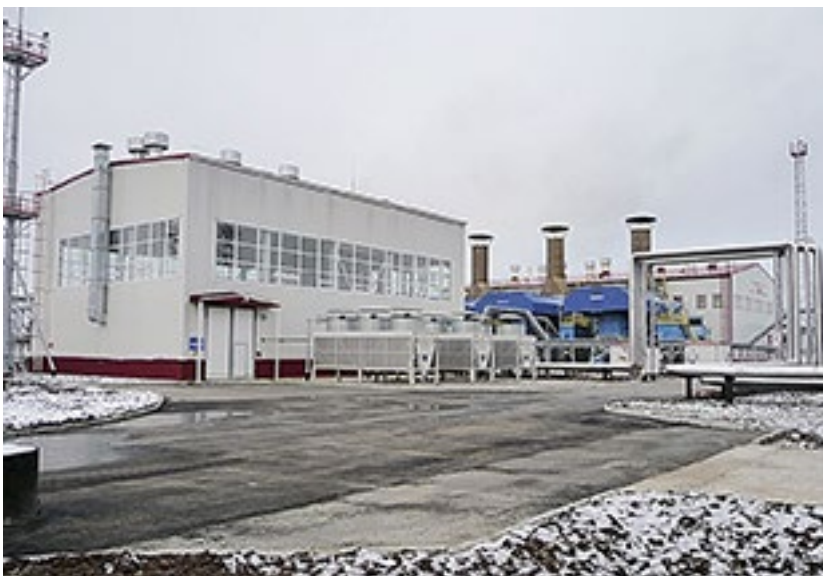
ФОТО 2. ДКС ангарного типа на ГТЭС №1 Рогожниковского месторождения
