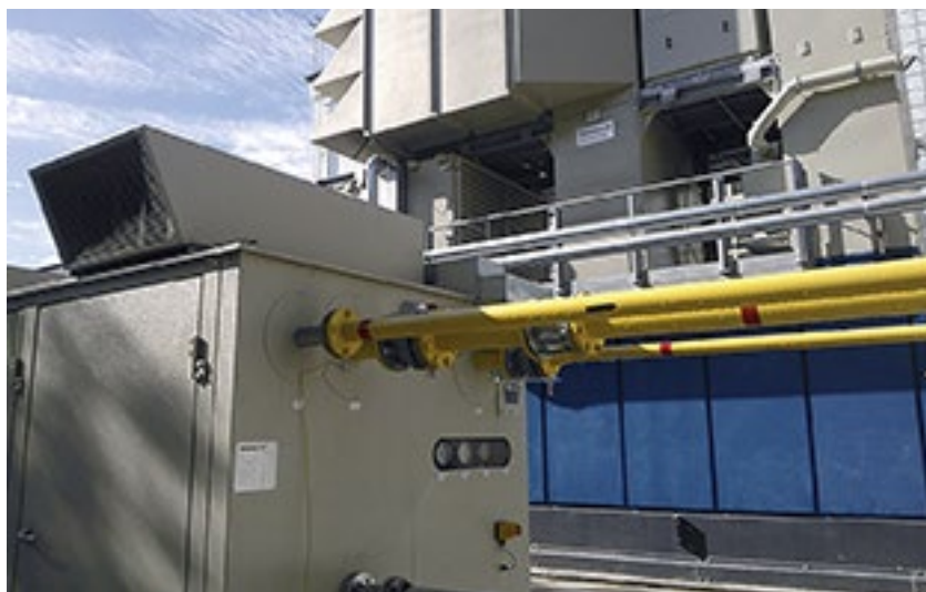
ФОТО 3. ГТЭС ОАО «Минский КСИ». GTU Turbomach и дожимная компрессорная установка
