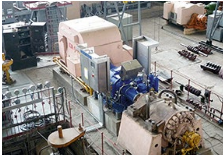
Регулирующие турбомуфты компании Voith обеспечивают высокую надежность приводной системы
