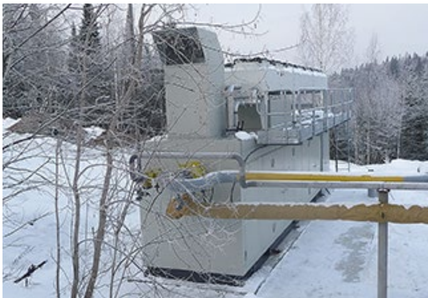
ФОТО 4. Оборудование газоподготовки на стенде для испытаний ГТУ Авиадвигатель-ПМЗ
