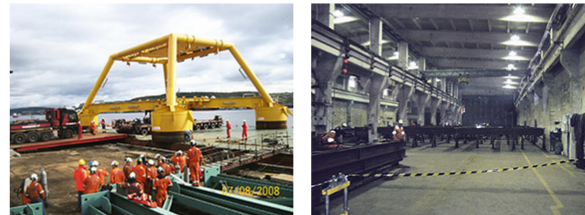
а – в 2008 году мурманское отделение «Reinertsen» построило защитную конструкцию подводного модуля для проекта «Sigrid» (Норвежское море) компании «Statoil Hydro»
