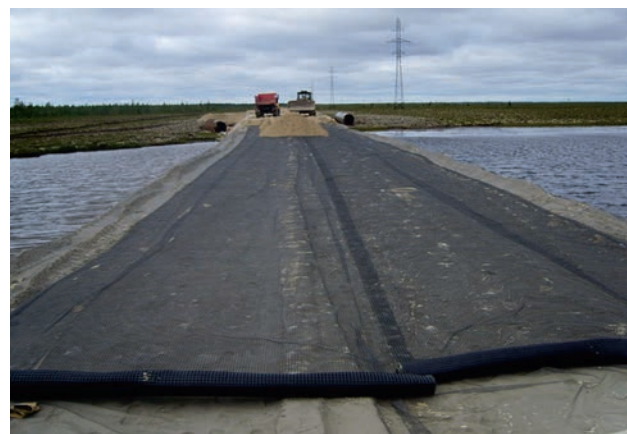
ФОТО 11. Применение дорожных сеток для автодорог с асфальтобетонным покрытием
