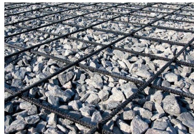
ФОТО 12. Композитная арматура для строительства бетонных автодорог
