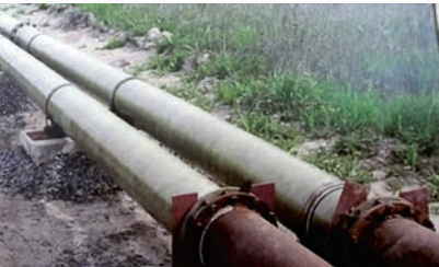
ФОТО 7. Композитные трубы теплотрассы. Замена стальных труб на композитные. Стыковка композитных труб со стальными фланцевыми соединениями. Отработаны несколько вариантов стыковки композитных труб между собой муфтовыми, байонетными и другими видами соединений
