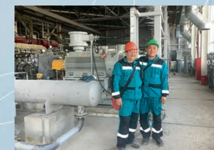
Сервис на площадке Сибур
