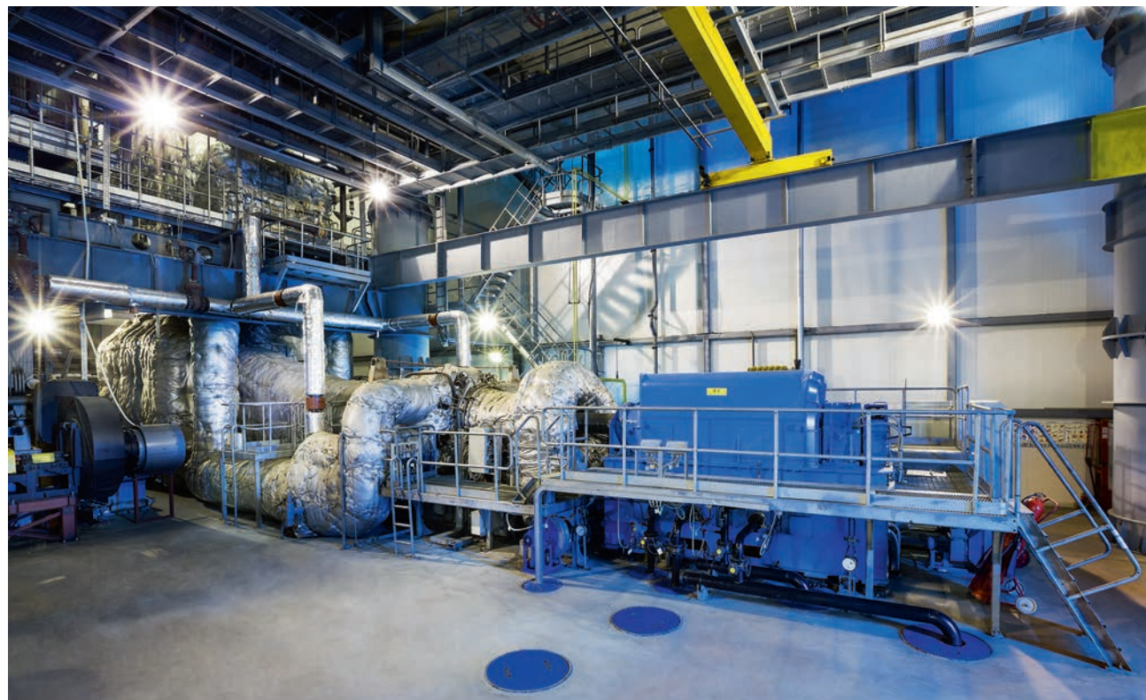
Полный цикл сервисных работ проводится непосредственно на объекте
