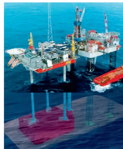
РИСУНОК 1. Мобильная платформа с жестким подводным нефтехранилищем MOPUstor
