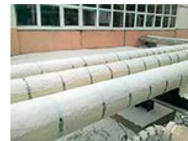
РИС. 4. Гибкий теплоизоляционный материал Pyrogel® XT
