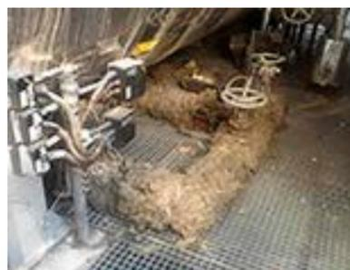
РИС. 1. Потерявшая свойства минеральная вата на технологическом оборудовании
