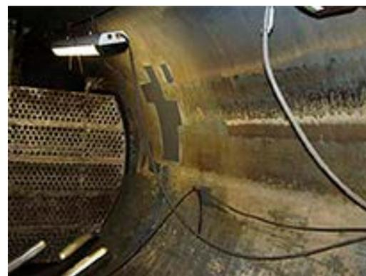
РИС. 2. Вид покрытия после ремонта заплатой
