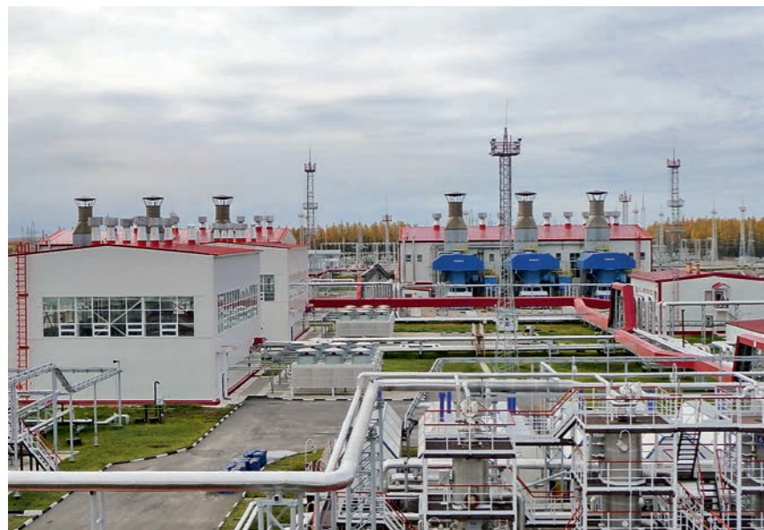
ФОТО 3. Топливом для газотурбинной электростанции Талаканского месторождения служит попутный газ
