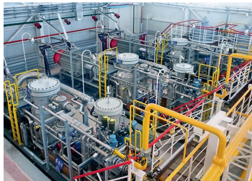
ФОТО 4. Установка подготовки топливного газа «ЭНЕРГАЗ» на Северо-Лабатьюганской ГТЭС
