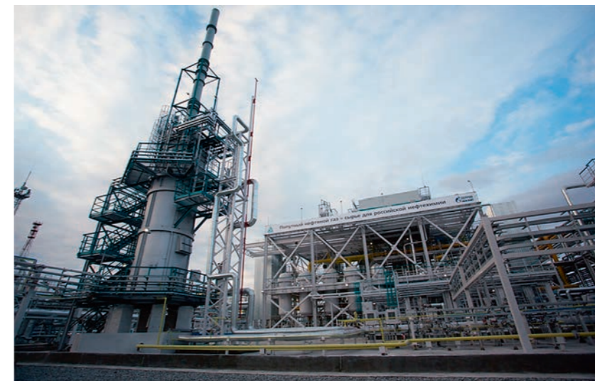
ФОТО 1. Вынгапуровский ГПЗ (СИБУР) построен для переработки попутного нефтяного газа
