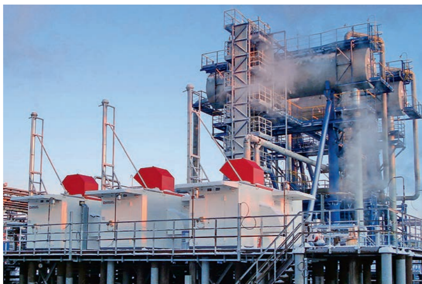
ФОТО 7. УПН Варандейского месторождения (ЛУКОЙЛ-Коми). ДКУ перекачивают ПНГ низкого давления
