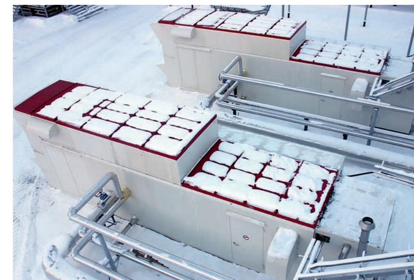
ФОТО 6. Винтовые ДКУ от компании ЭНЕРГАЗ на объекте НГДУ «Лянторнефть» (Сургутнефтегаз)
