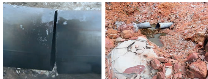
РИС. 1. Разрушение сварных соединений газопроводов в горных условиях: а) ООО «Баштрансгаз», б) SSGP
