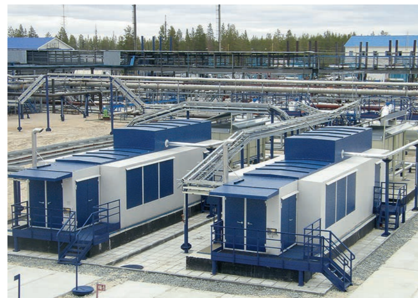
ФОТО 8. Вакуумные КУ работают на ДНС-3 Вынгапуровского промысла ОАО «Газпромнефть-Ноябрьскнефтегаз»
