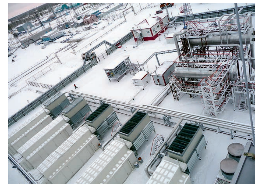
ФОТО 2. Алевинское месторождение ОАО «Сургутнефтегаз». СКНС для транспортировки ПНГ
