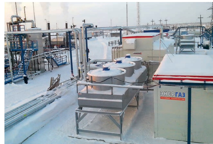
ФОТО 5. Компактный комплекс газоподготовки: ДКУ, осушитель газа, чиллер
