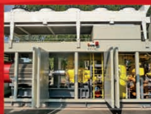
ПУСКОНАЛАДКА И ИСПЫТАНИЯ
