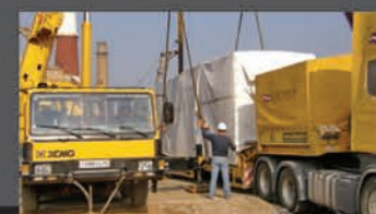
Доставка и монтаж
