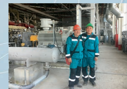
Сервис на площадке Сибур
