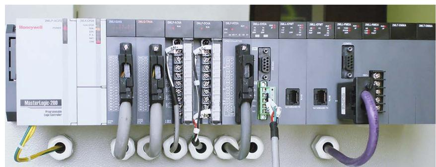
РИС. 2. Современные модульные и масштабируемые ПЛК позволяют создавать мощные и надежные приложения, реализующие высокоскоростную логику и управление последовательностями операций
