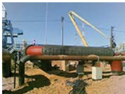
Применение огнеупорных теплоизоляционных материалов на газовой компрессорной станции
