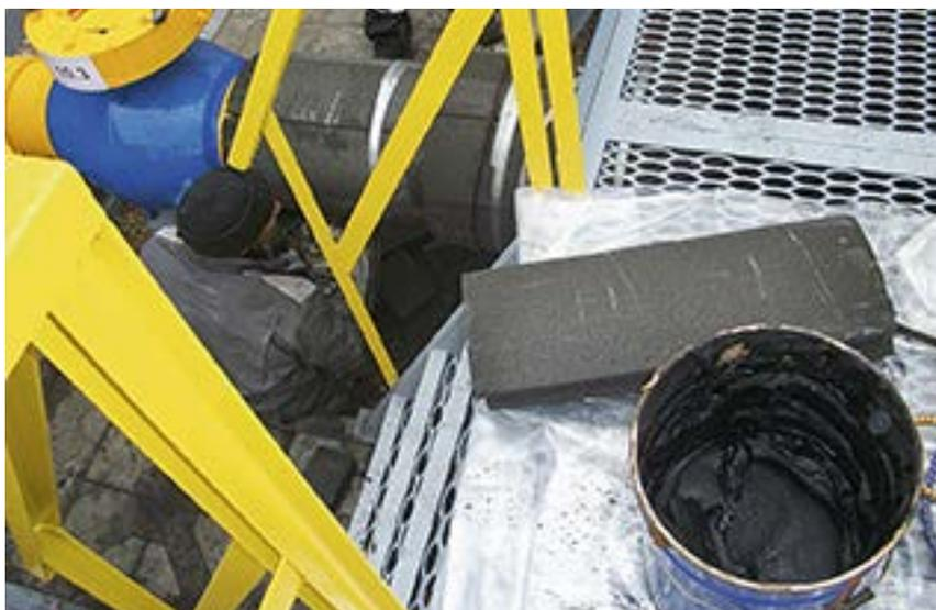
Монтаж противопожарной вставки на газопроводе
