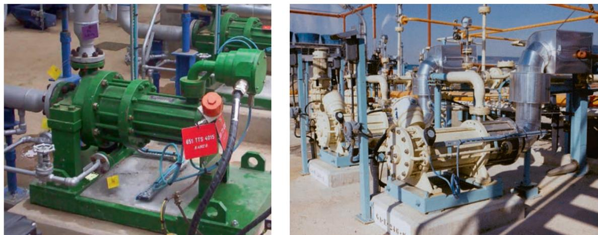
РИС. 6. Многоступенчатые насосы HERMETIC
