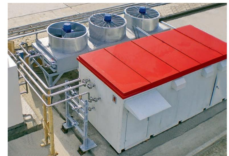
ФОТО 4. Адсорбционный осушитель для дополнительной осушки попутного газа на ЦПС Западно-Могутлорского месторождения ОАО «Аганнефтегазгеология»
