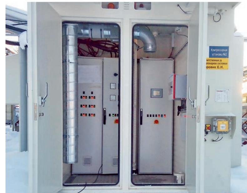
ФОТО 7. Отсек САУ компрессорной установки на КС Мурьяунского месторождения
