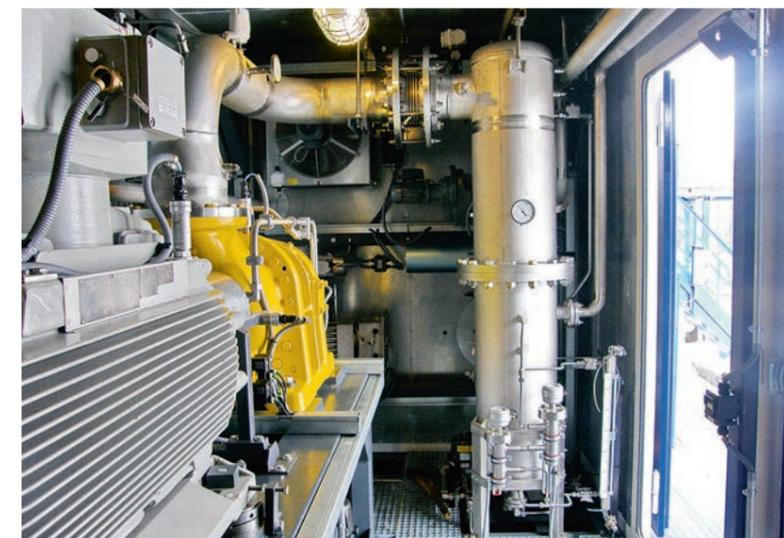
ФОТО 3. Фильтр-скруббер встроен в блок-модуль вакуумной компрессорной установки «ЭНЕРГАЗ» на ДНС-1 Вынгапуровского м/р ОАО «Газпромнефть-Ноябрьскнефтегаз»
