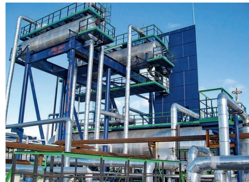
ФОТО 1. Разделительные сепараторы на установке подготовки нефти
