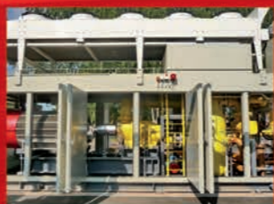
ПУСКОНАЛАДКА И ИСПЫТАНИЯ
