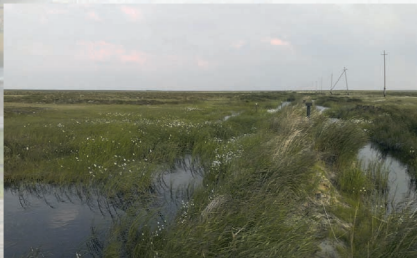
РИС. 2. Вид участка исследований. Образование термокарста и всплытие газопровода
