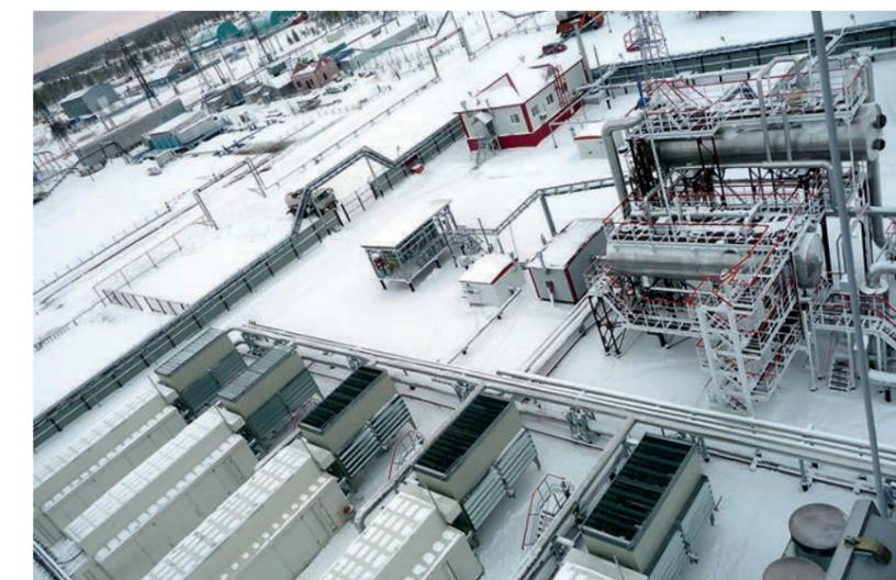
ФОТО 2. Алевинское месторождение (Сургутнефтегаз). На компрессорную станцию низких ступеней сепарации поступает ПНГ из нескольких источников
