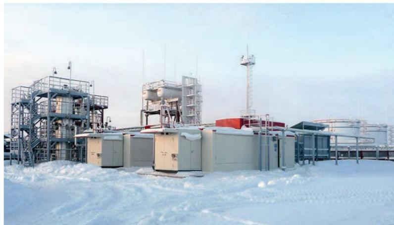
ФОТО 3. ДНС-3 Северо-Лабатьюганского месторождения. Компрессорные установки перекачивают попутный газ с отрицательными значениями по давлению на входе (от -0,02 МПа изб.)
