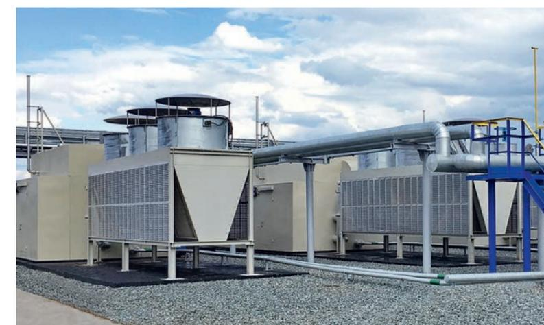
ФОТО 6. Аппараты воздушного охлаждения (АВО) компрессорных установок
