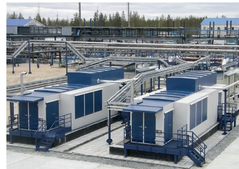
ФОТО 5. Вакуумные компрессорные станции «ЭНЕРГАЗ» для ЦПС ДНС-3 Вынгапуровского м/р (Газпромнефть-ННГ) проектировались специально для НН ПНГ с давлением 0,001 МПа
