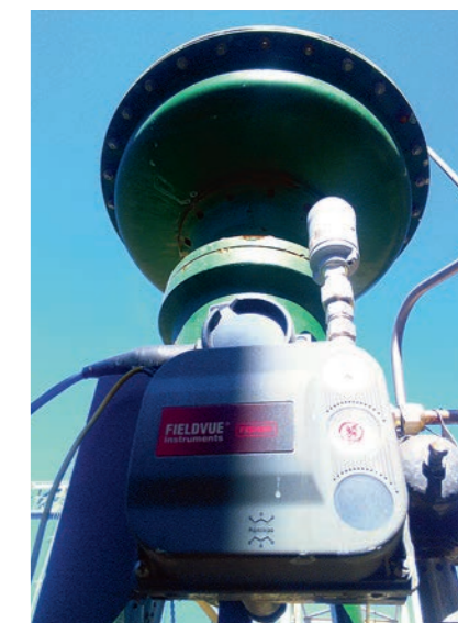
РИС. 2. Клапаны с интеллектуальными электропневматическими позиционерами FIELDVUE DVC
