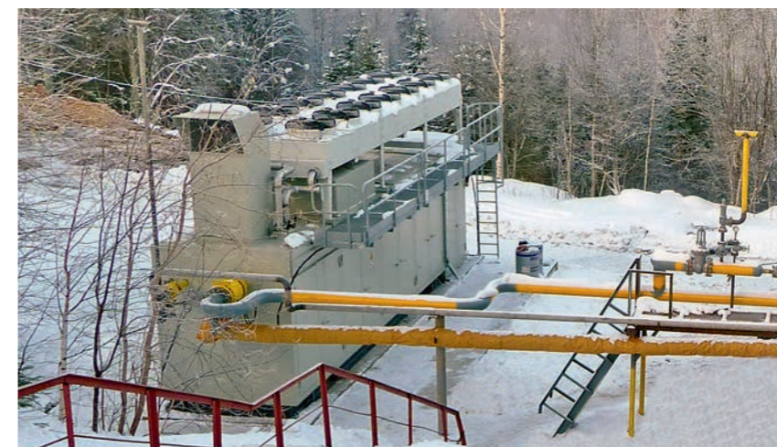
ФОТО 5. Дожимная компрессорная станция «ЭНЕРГАЗ» для стенда «Протон-ПМ»
