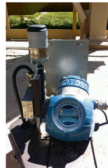
РИС. 1. Радарный уровнемер 5400 с преобразователем Rosemount 775
