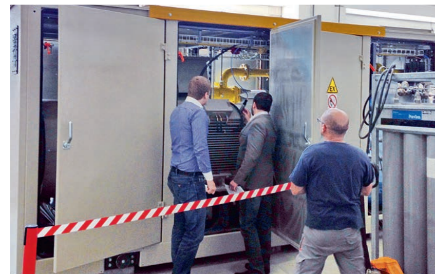
ФОТО 9. Заводские испытания оборудования газоподготовки для ПГУ ТЭЦ МЭИ с участием специалистов заказчика
