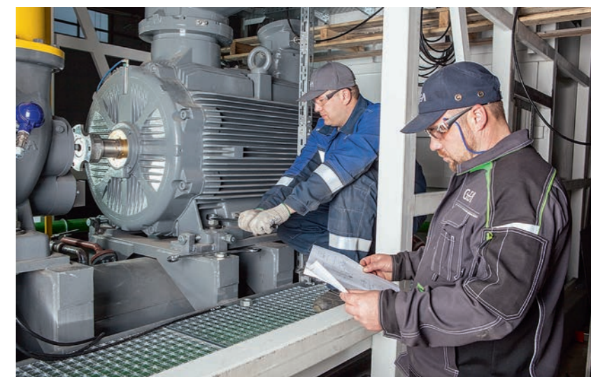
РИС. 2. Сборка дожимной компрессорной станции GEA Сириус, Климовск, Цех №1
