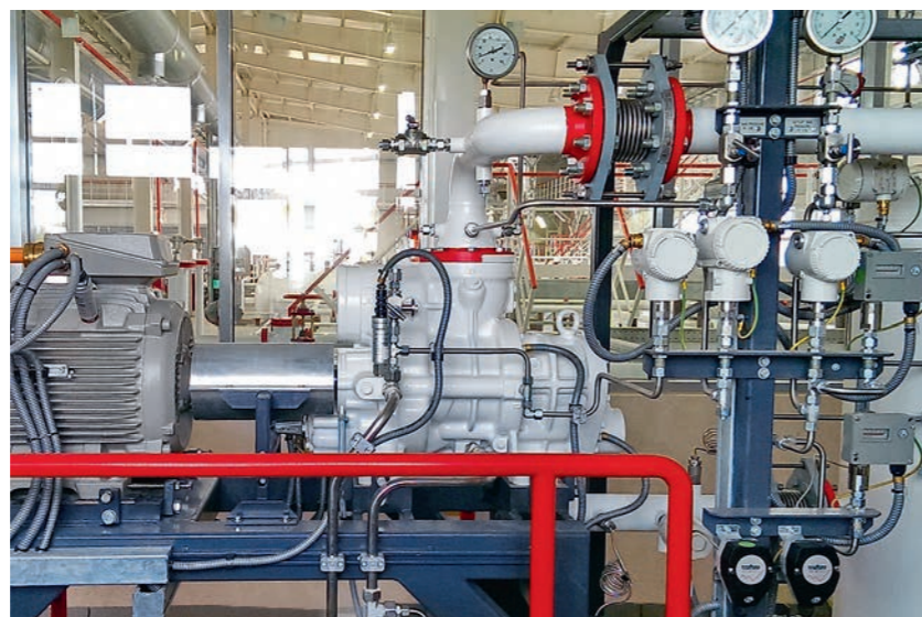
ФОТО 8. Компрессорная установка-симулятор для Учебного центра ОАО «Сургутнефтегаз»
