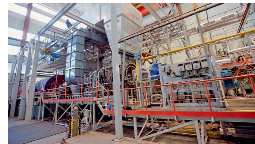
ФОТО 6. Испытательный цех «Невского завода»
