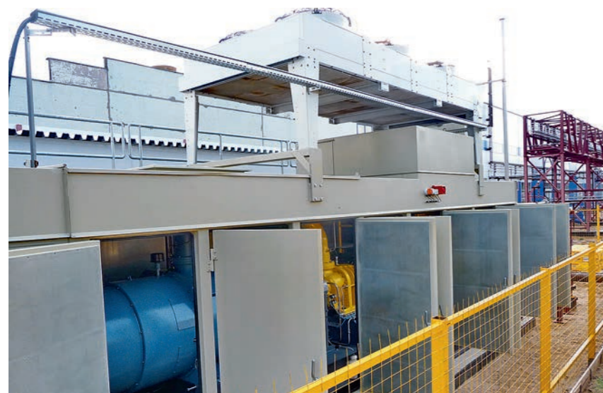
ФОТО 3. ДКС снабжает топливом испытываемые турбины и газоперекачивающие агрегаты
