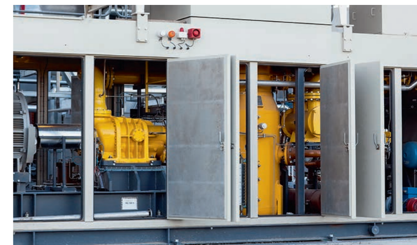
ФОТО 7. ДКС обеспечивает турбины газом с проектными параметрами по чистоте, давлению и температуре
