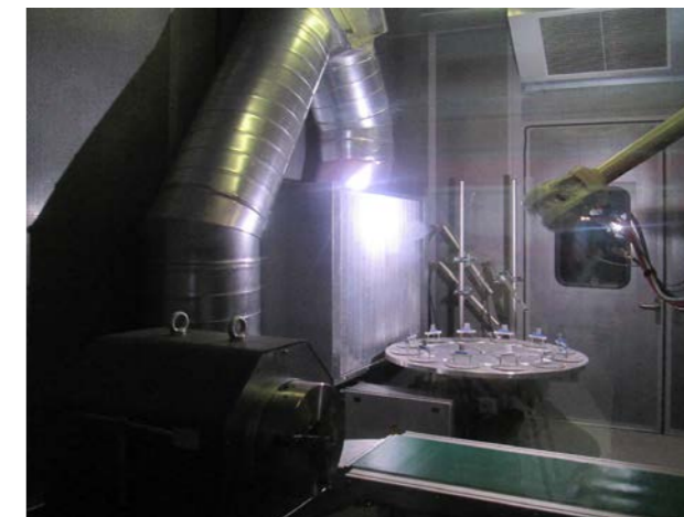
Участок нанесения покрытий
