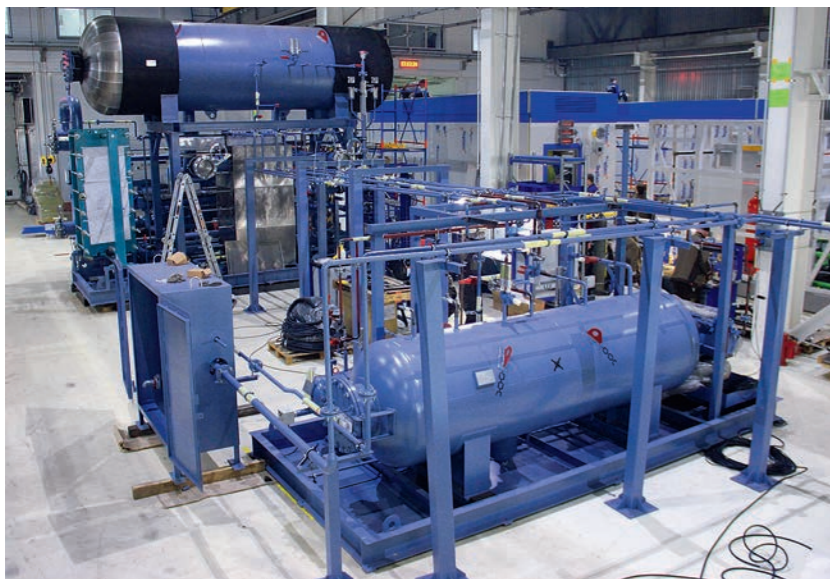
РИС. 3. Сборка блочно-модульной холодильной машины GEA, Климовск, Цех №1
