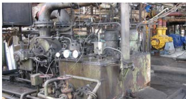
Рис.2 В установке «Дуосол-22»: на переднем плане – Н 360-500сг, на заднем плане – АНМСг 450-500
